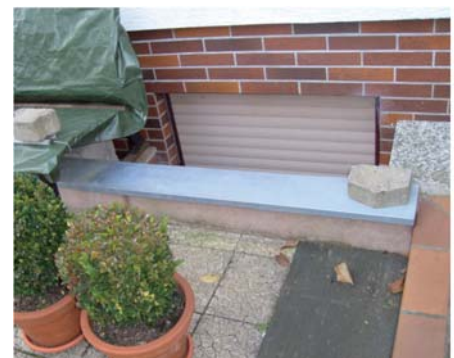
Hochgemauerte Kellerfensterschächte (Quelle [5])
