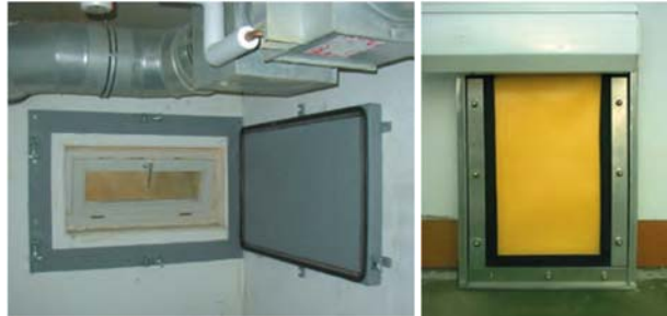
Druckdichtes Fenster (links) und spezielle Folienabdichtung (rechts) (Quelle [1])
