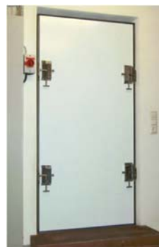
Hochwasserbeständiger Türeinsatz (Quelle [1])
