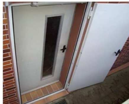
Zusätzliche wasser- und druckdichte Außentür (Quelle [5])
