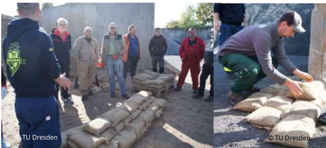
Abbildung 3: Beispielfotos aus dem Helferpool der Stadt Glashütte (Sandsackdamm links, Damm um Türöffnung rechts)
